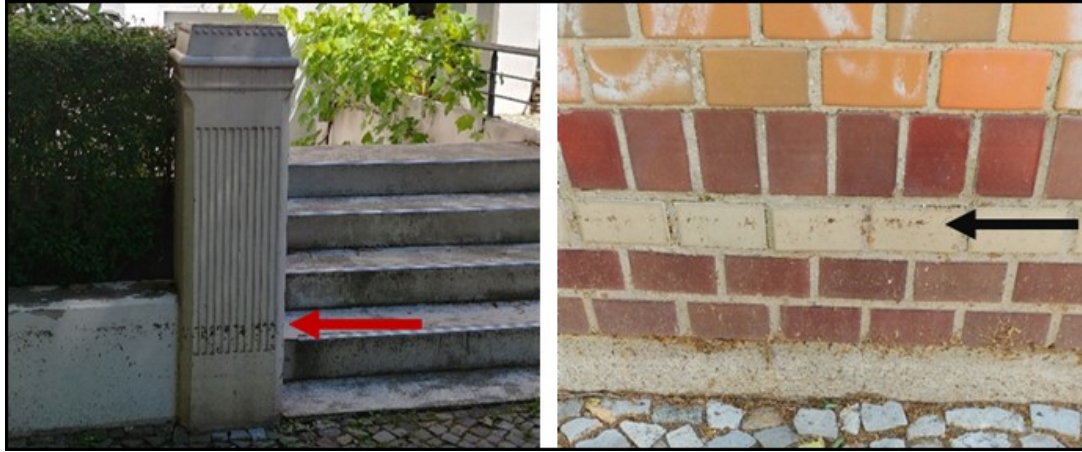
Maximaler Wasserstand während Starkregeneignis vom 11. und 12.06.2019; ableitbar aus Blütenrückständen auf der Oberfläche (jeweils durch Pfeil markiert) (Fotos: Gunther Pahl, BWB)
